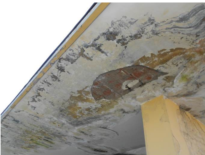
Foto 4.15 – vista interna dei solai orizzontali
