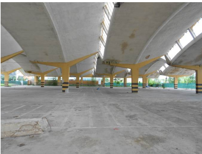
Foto. 4.13 – Interno della Tettoia "Nervi"
