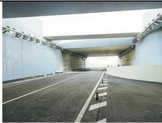
▲ Una veduta del tunnel che passa sotto i binari della stazione di Bologna
